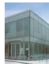
Fujitsu General (UK) Co., Ltd. (UK)
